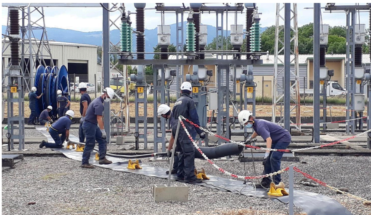
Exemple de balisage dans un poste électrique lors du déroulage d'une canalisation isolée
