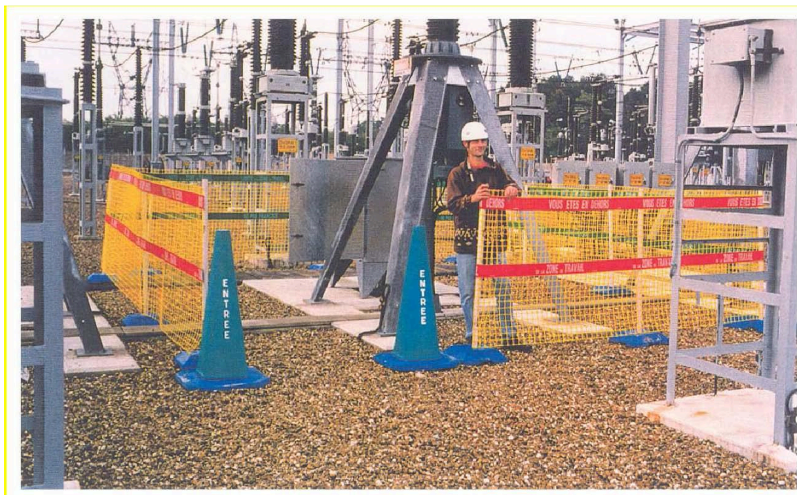
Exemple de balisage de zone dans un poste électrique HTB en exploitation
