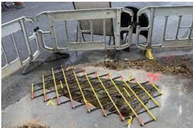
Exemple de balisage rigide en cas de risque de chute
