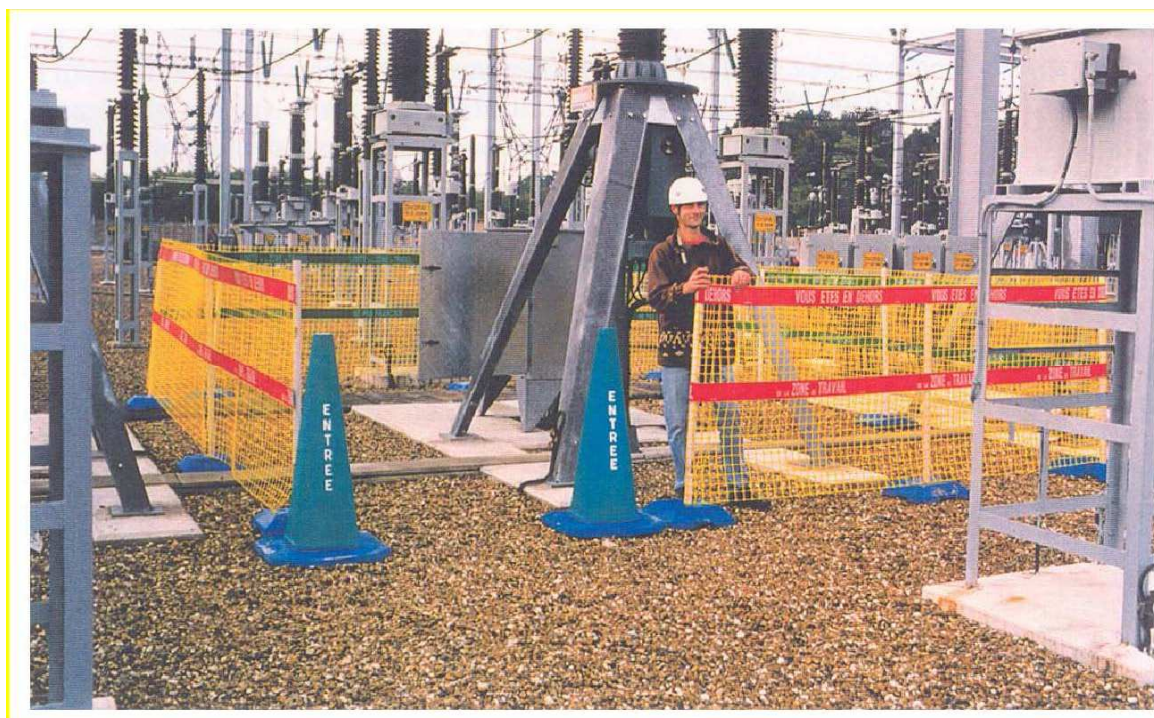
Exemple de balisage de zone dans un poste électrique HTB en exploitation
